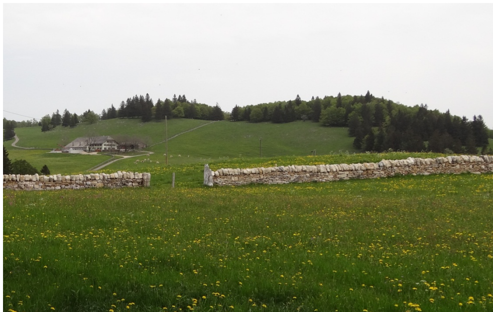
Mur de pierres sèches, Pré Richard (photo : OACOT, F. Baumann)
